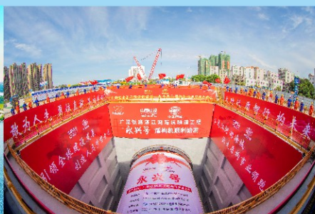
广湛高铁湛江湾海底隧道
