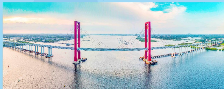
调顺跨海大桥贯通东西两岸，海湾变通途
