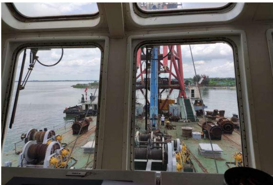
图 3：从“中铁桩 1”轮驾驶台起吊操纵台看向起吊现场
