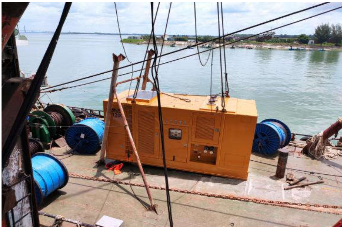
图 4：从“中铁桩 1”轮船首架柱上看向起吊现场
