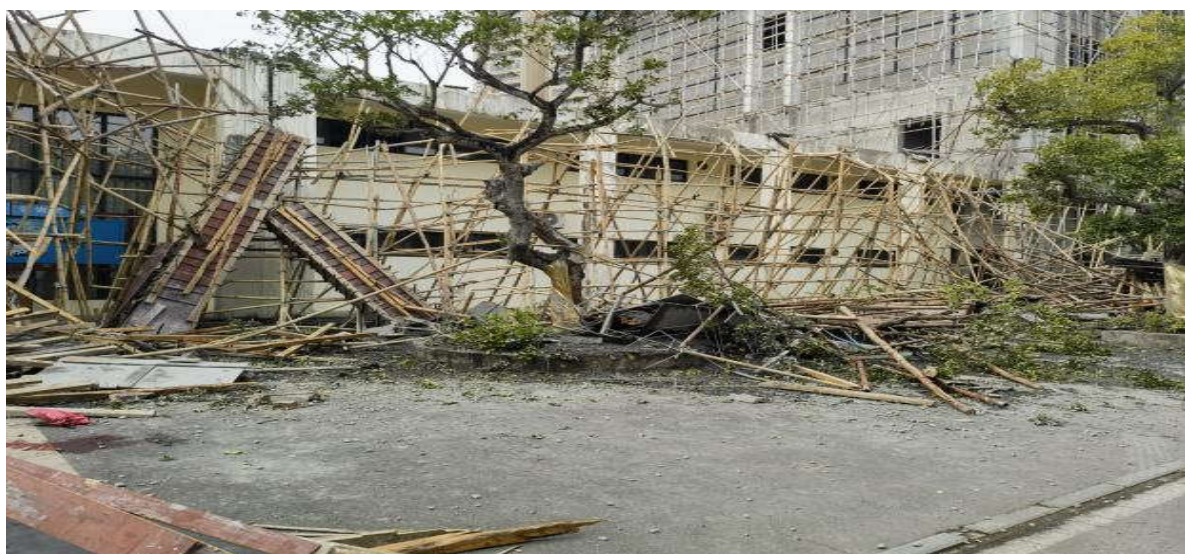
图3 竹架上和地面上见有倒塌的水泥柱
