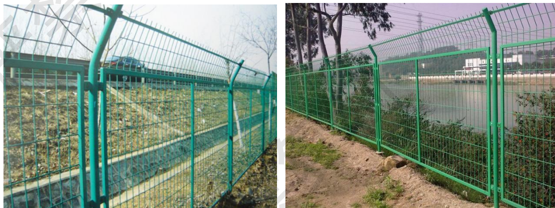
图 3.1-1 隔离网实物图
