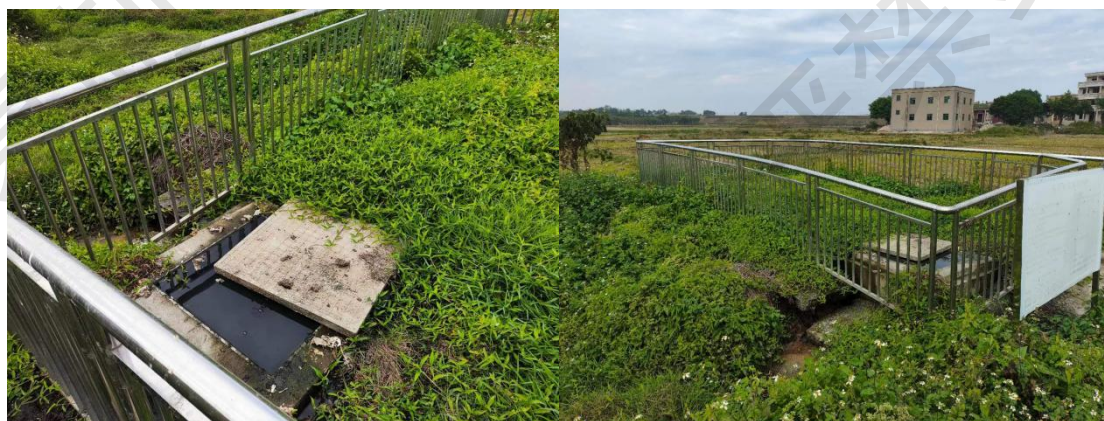
图 2.3-3 下甘村农村生活污水处理设施现场图
