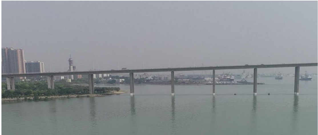
图 5.1.2-4 湛江海湾大桥
