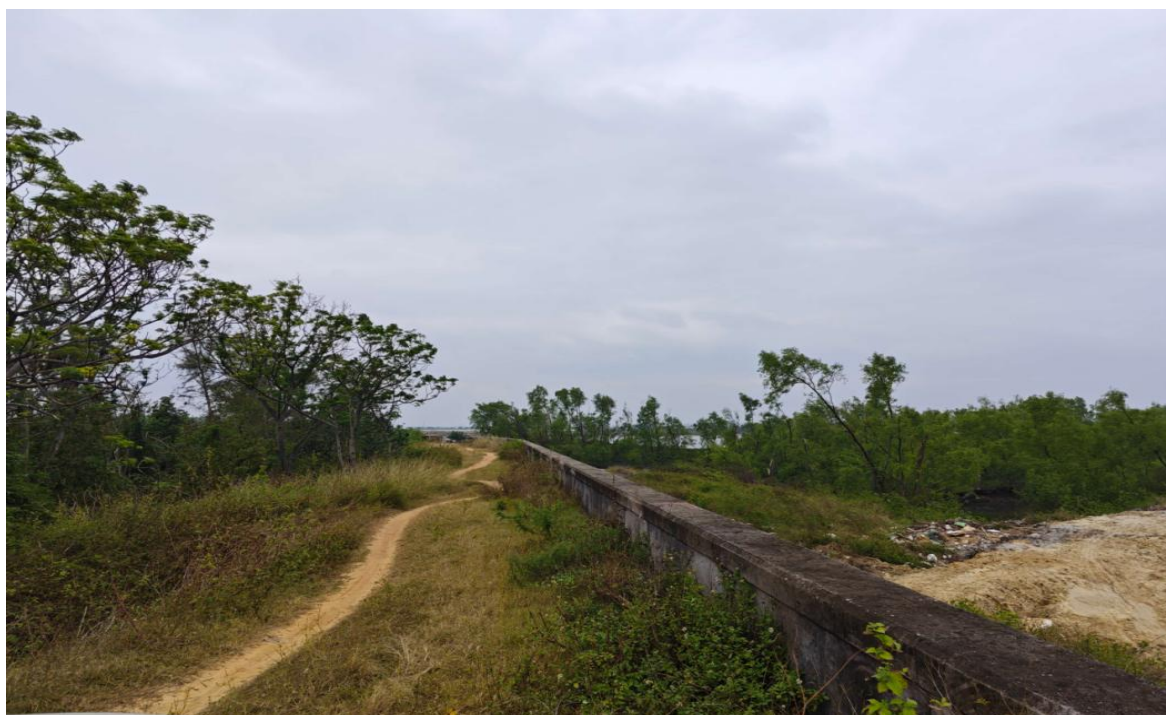
图 4.3-3 米擒堤（现状堤顶路面未硬化）
