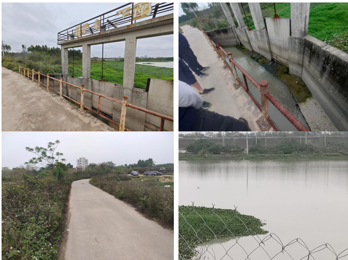
现有前置库水闸、道路及隔离情况
