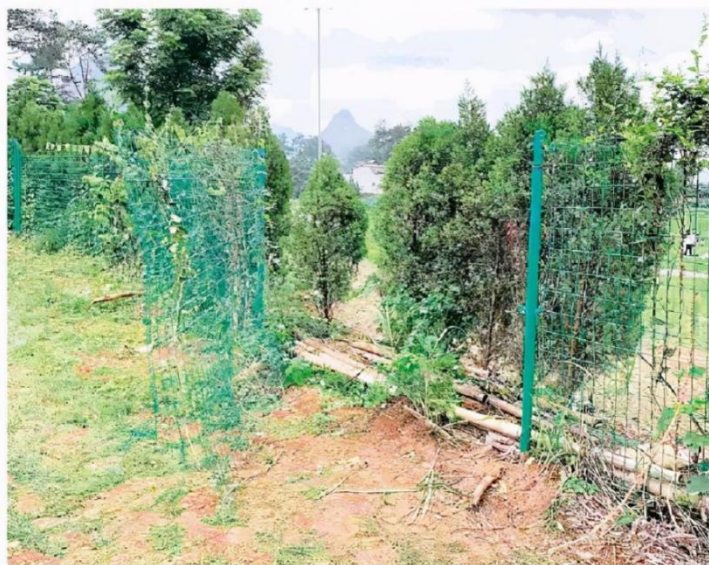
图 3.1-4 甘村水库西侧前置库原有隔离防护网破损实拍图
