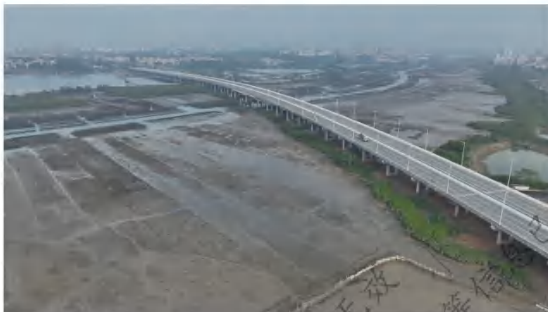
图 5.1.2-2 湛江市官渡海围、消坡海围大桥
