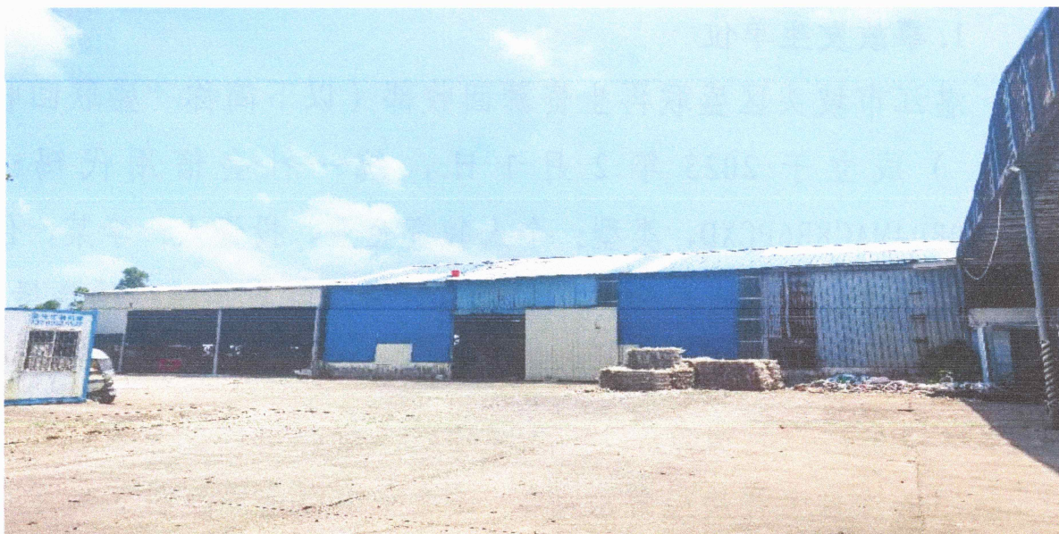
图1 涉事厂房外部
