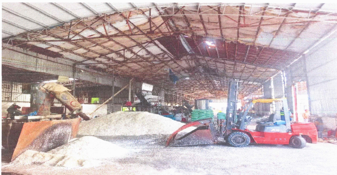
图2 涉事厂房内部
