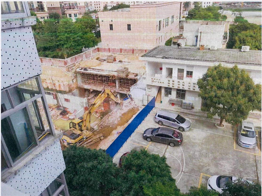
（工地施工正在挖我局附属房前水泥地台）
