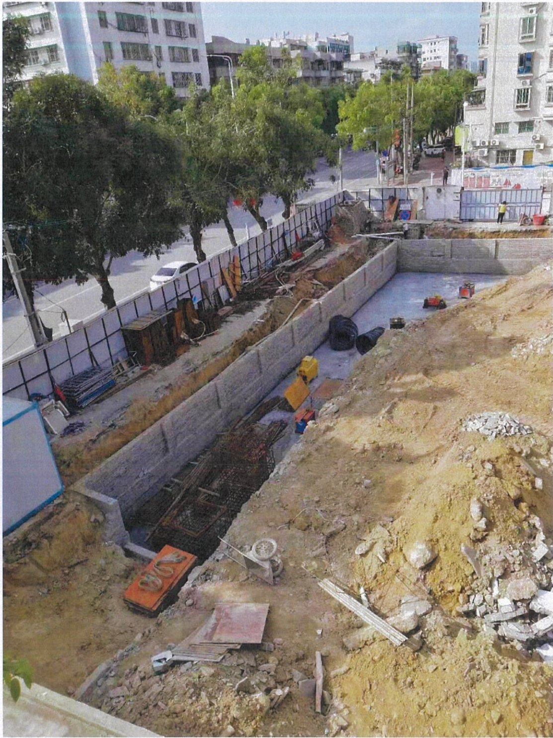
(工地继续施工砌起砖墙)
