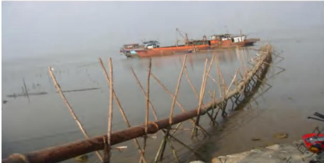
图 2.3.1-4 从岸边到吹填区域排泥管架设示意图
