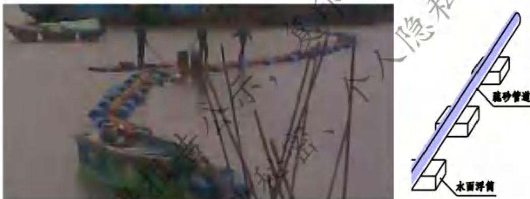
图 2.3.1-3 从绞吸船到岸边段排泥管架设示意图
